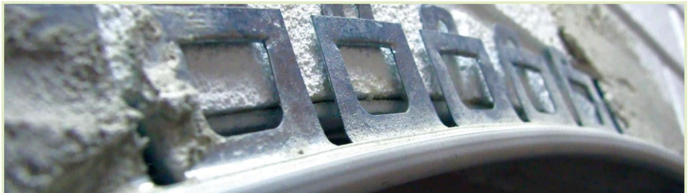
**Kantenprofile aus Hart-PVC**
